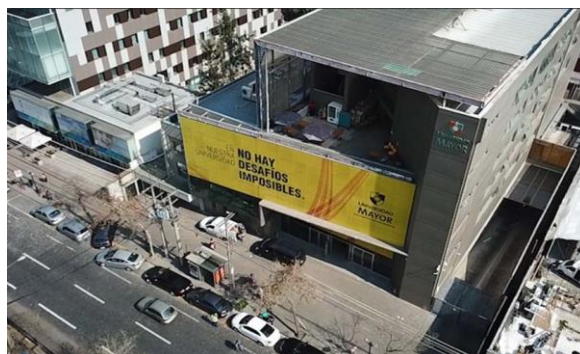
Figura 3. Vista aérea del Campus Manuel Montt
